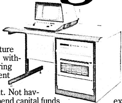
a DS10 Disk Drive, an 810 Printer, DX10 Operating System, Sort/Merge, and optional COBOL.
